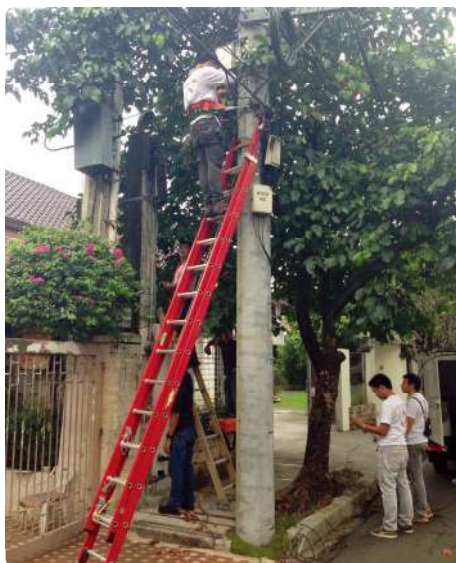
Работа с KF4A на лестнице вне помещения
